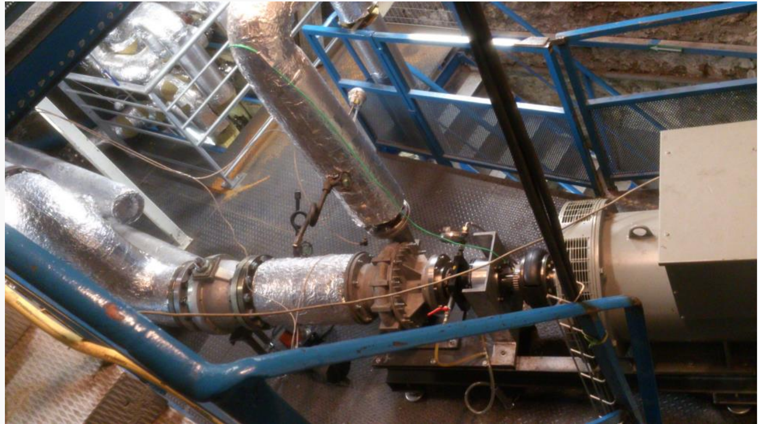
Proyecto ERC SYNERGY - Sistema ciclo ORC completo 150 kW (SES36)
